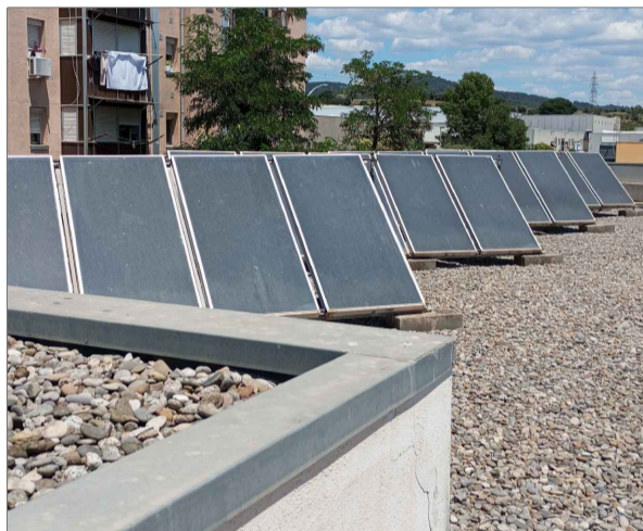
ES RETIRARÀ LA INSTAL·LACIÓ SOLAR TÈRMICA EXISTENT ABANS DE REALITZAR EL REPLANTEIG EN OBRA DE LA INSTAL·LACIÓ FOTOVOLTAICA. ES SEPARARÀ HIDRÀULICAMENT EL PRIMARI DEL SECUNDARI.
